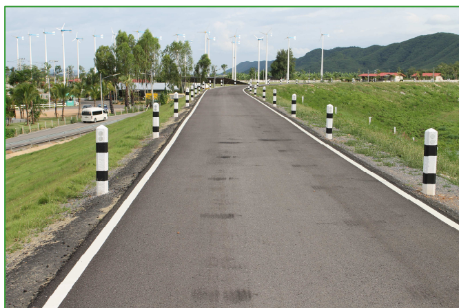
ถนนบนสันอ่างเก็บน้ำหนองเสือ
