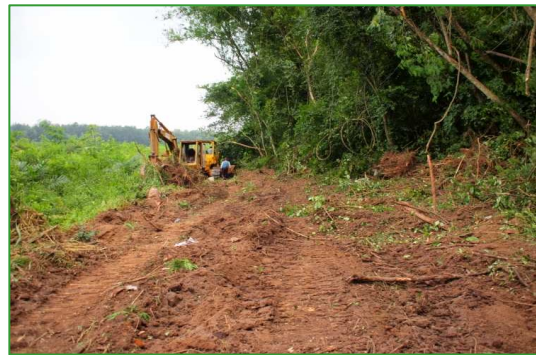
งานก่อสร้างระบบท่อส่งน้ำ
